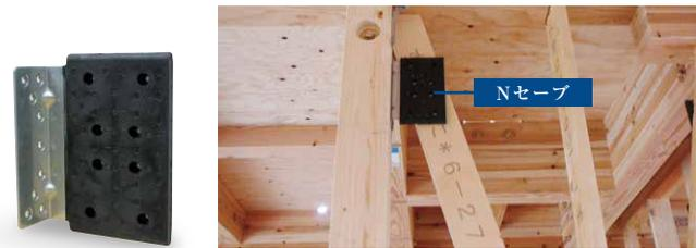
構造材の接合部分を強化するための、耐震金物に制震ゴムを付加し、構造強化と制震性を同時に担保する先進的な構造部材。大学の学術研究に基づいて開発された製品であり、関西ではいち早くN·istが導入しました。
